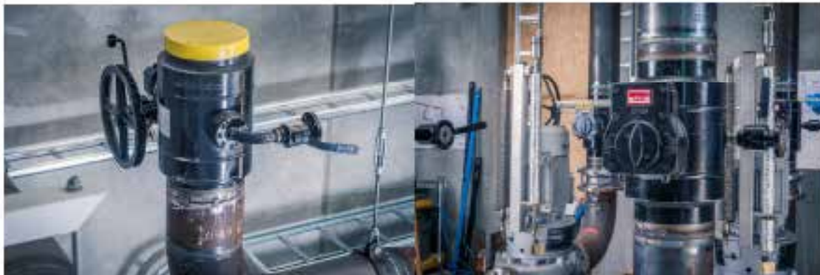
BROEN Ballomax® DN250 – DN400 ventiler – Dobbelt lejet ventilkugler med Double Block and Bleed og udtag – under svejsning i Holbro Rjernværk.
