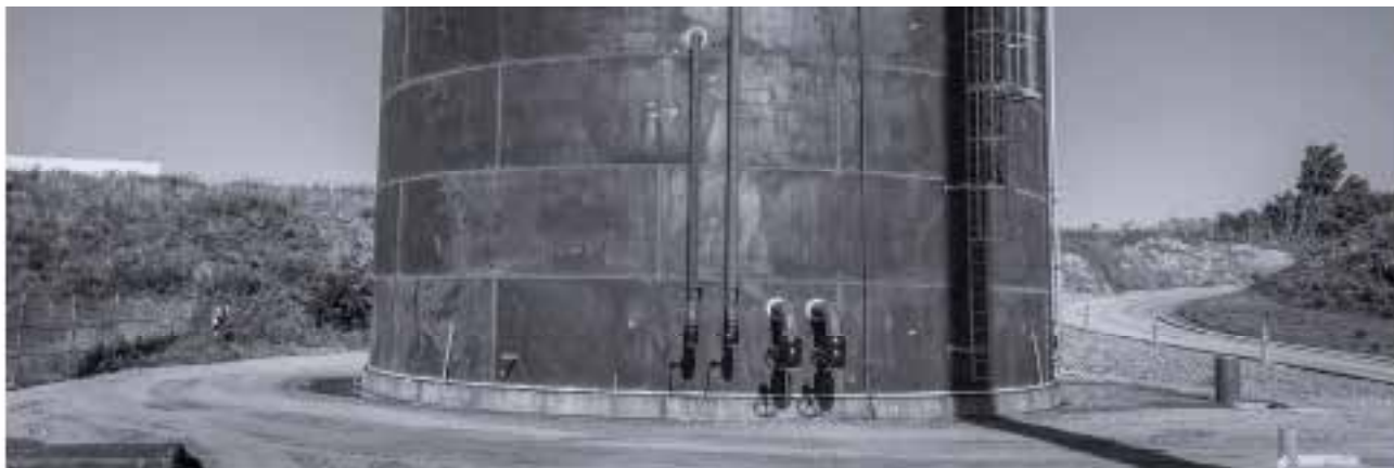
Hobro Fjernvarme – opførsel af nyt fjernvarmeanlæg med BROEN Ballomax® ventiler.
