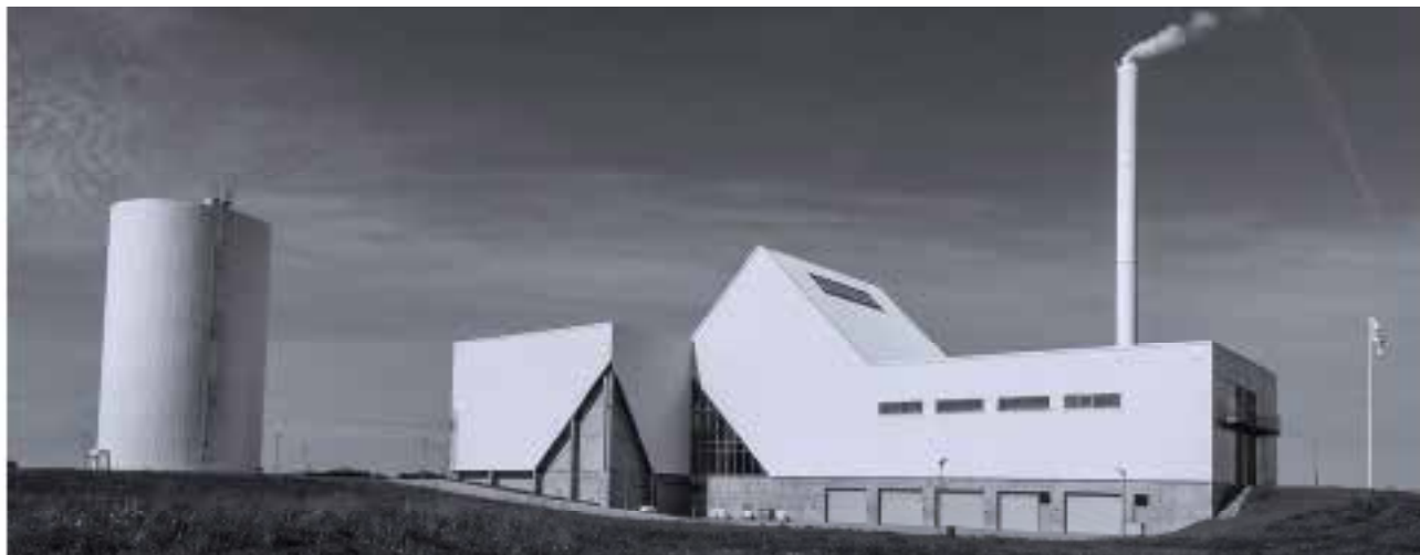
Aabybro Fjernvarmeværk (Danmark).
