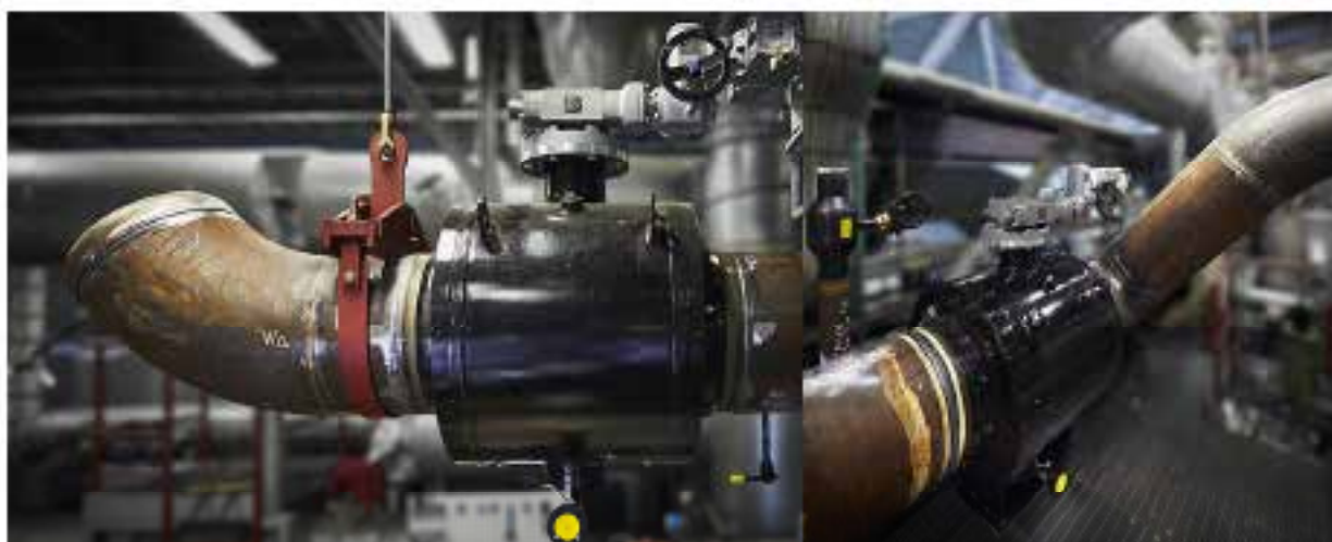
BROEN Ballomax® CBP – Dobbeltlejet ventilmønstre med Double Block and Bleed – CBP – ventilen er i lukket stand
