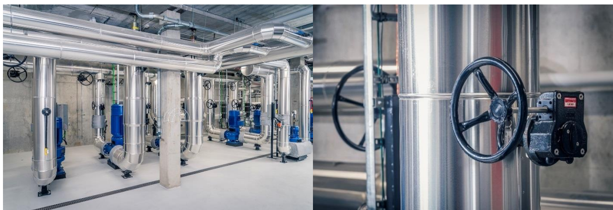
BROEN Ballomax® kugleventiler styrer flowet i fjernvarmevandet
