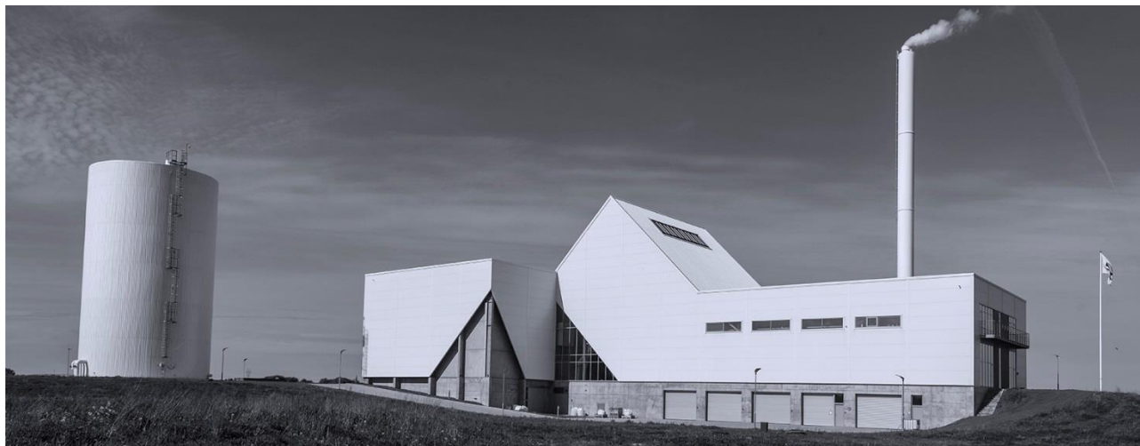
Aabybro Fjernvarmeværk (Danmark).
