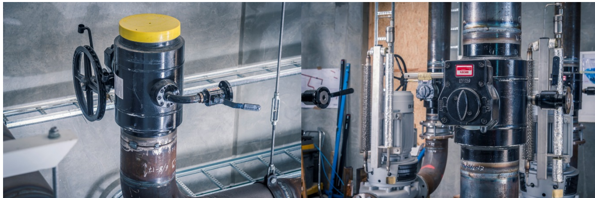
BROEN Ballomax® DN250 – DN400 ventiler – Dobbelt lejret ventilkugler med Double Block and Bleed og udtag - under svejsning i Hobro Fjernvarme.
