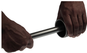
FIGUR 5: AFGRATNING AF RØRET
